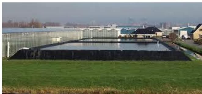
**Figura 8** - Receção da água da condensação e da água de drenagem para reutilização como água de irrigação
