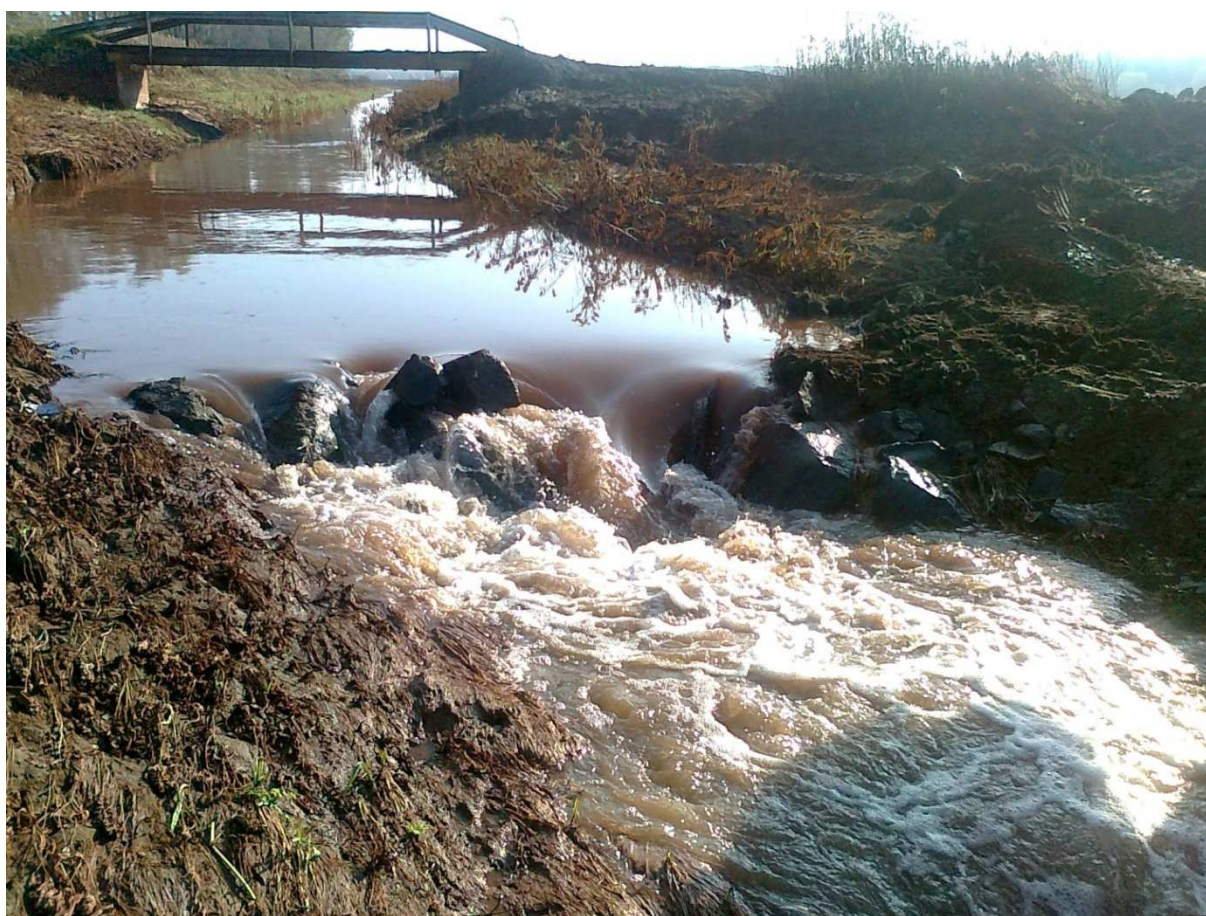
5. Barrage dans le lit de la rivière
