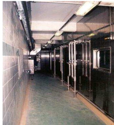
Vue extérieure de l'enceinte à revêtement acier (DR)
