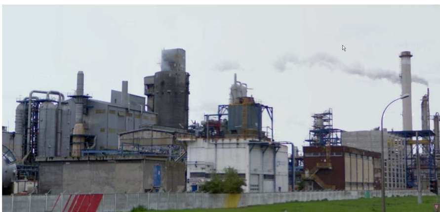
Figure 1 : Vue extérieure du site (source : Google)
