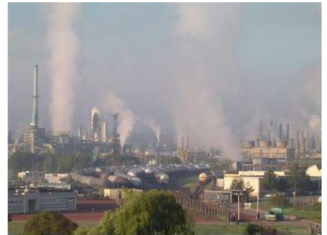
Figure 1 : Vue extérieure du site (DR)
