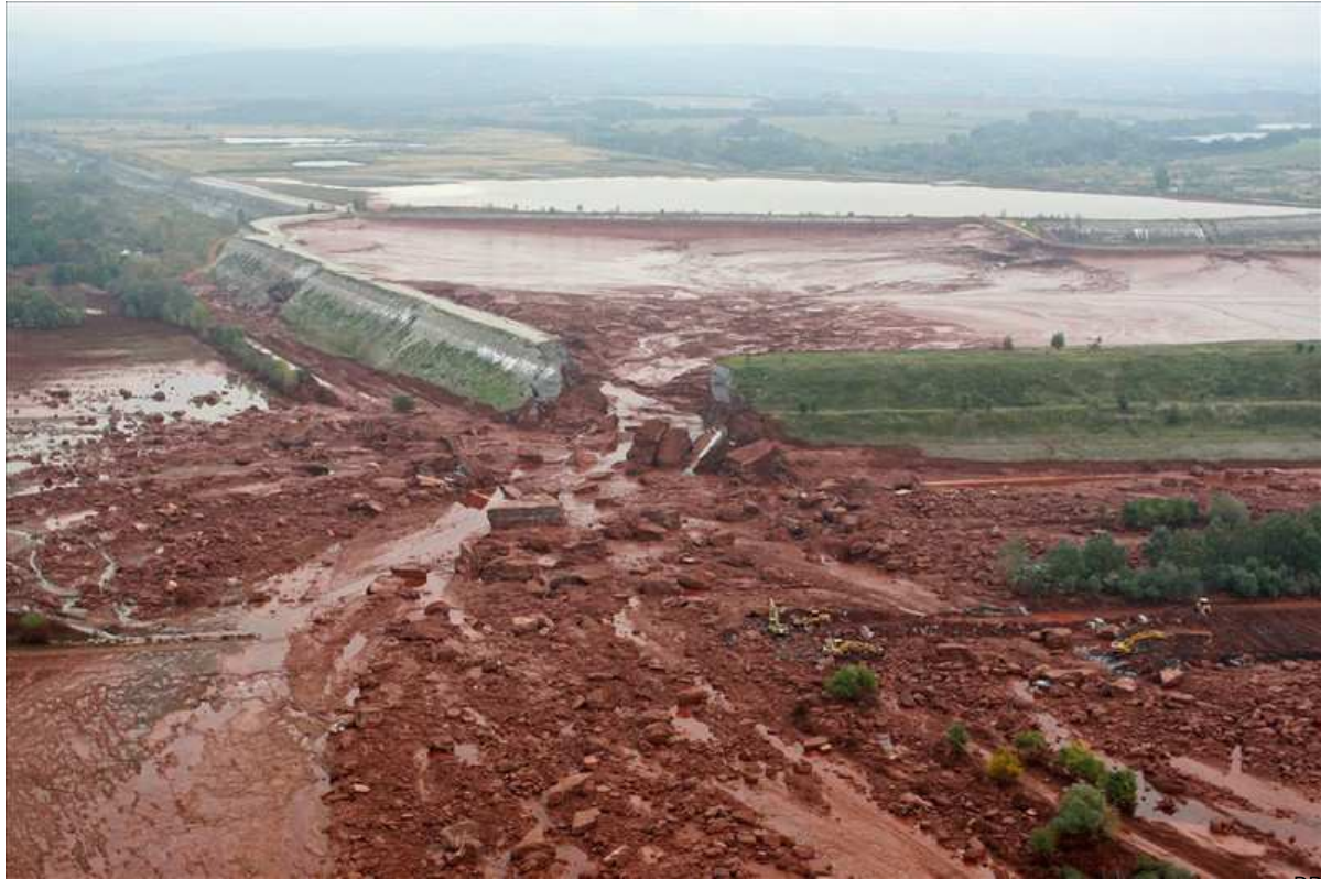
3. Enceinte après la rupture
