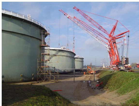
Figure 4: Grandes grues utilisées pour stabiliser le réservoir D2
