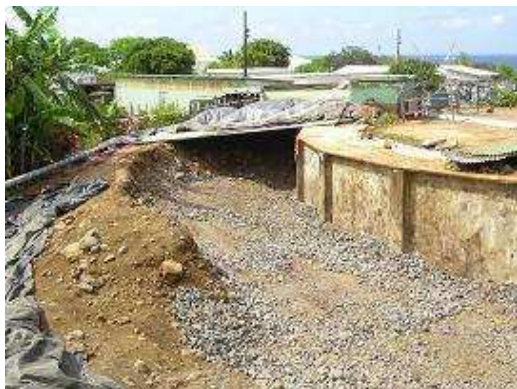
▲ Remblaiement autour du bac SEA2
