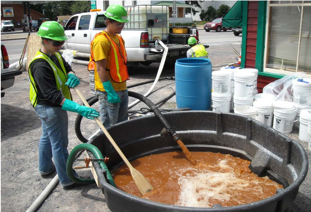
Figure 2.5 – Mélange des réactifs avant l'injection
