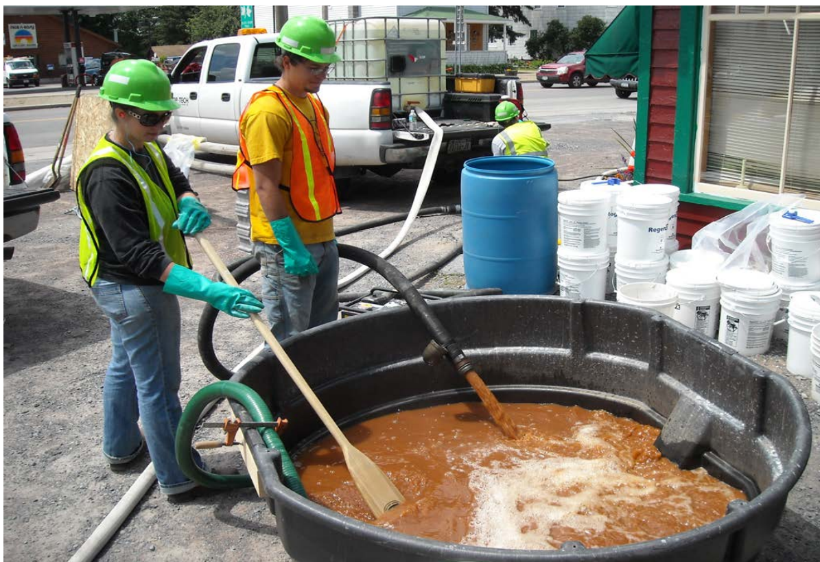
Slika 2.5- Mešanje reagentov pred vbrizgavanjem
