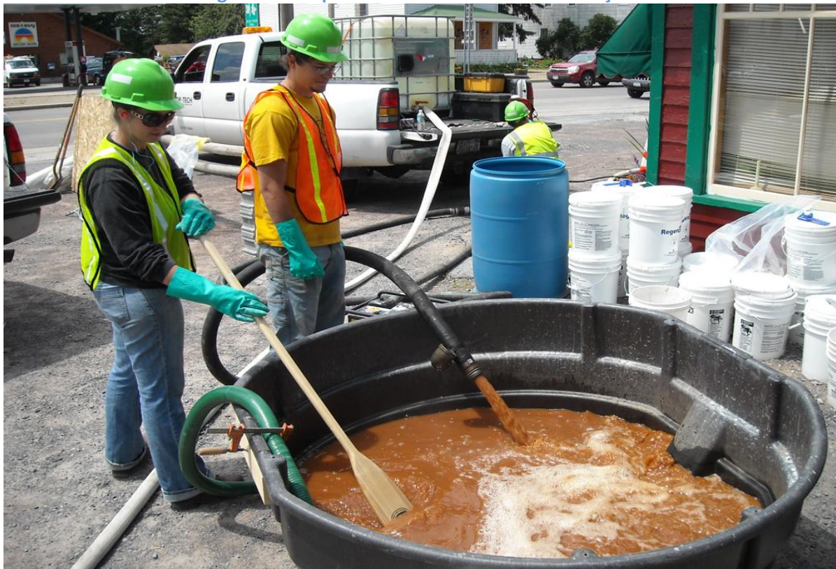
Figura 2.5- Mistura de reagentes antes da injeção
