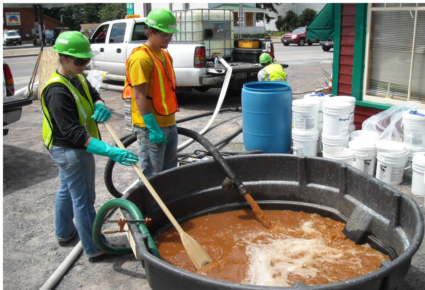
Figura 2.5- Mezcla de reactivos antes de la inyección
