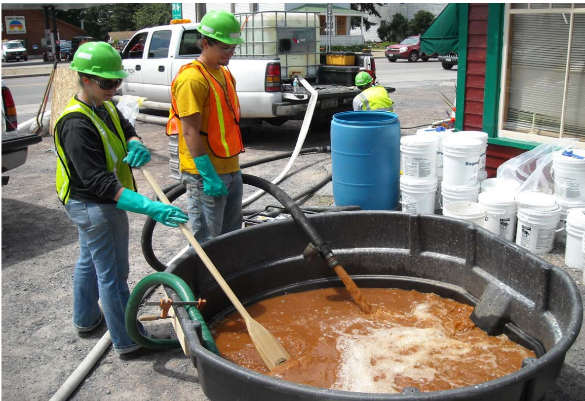
Εικόνα 2.5- Ανάμιξη αντιδραστηρίων πριν από την έγχυση
