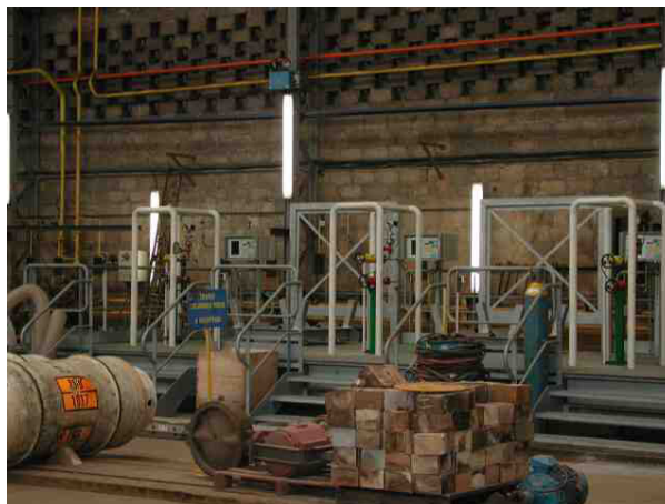
Hall de remplissage fermé
