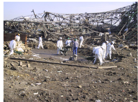
Chantier de déblaiement du site
