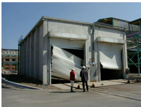
Bâtiment abritant le stockage de chlore et des wagons
