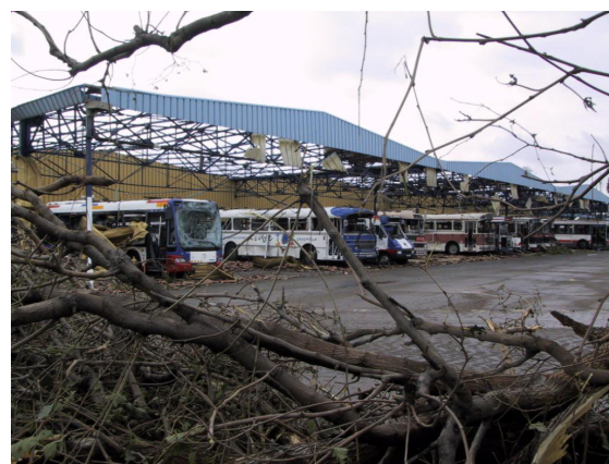
Dépôt de bus dévasté
