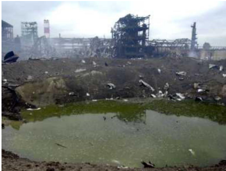
Cratère formé par l'explosion (point zéro)
