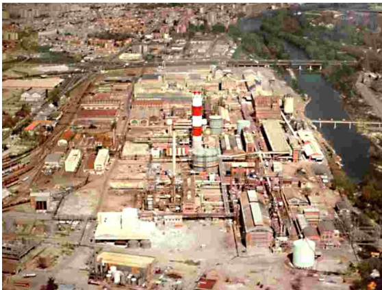
Usine Grande Paroisse
