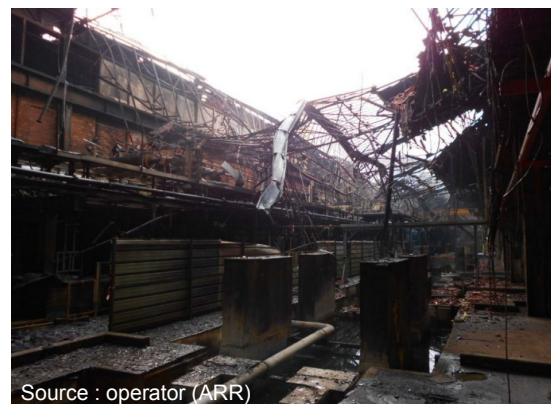
Source : operator (ARR)
